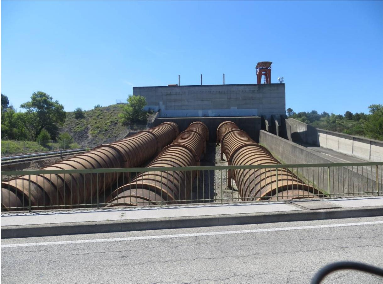
*Figure 59 conduites forcées de l'usine hydroélectrique de Millemort*
